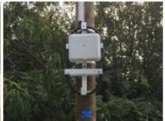
Point de branchement optique (PBO)
